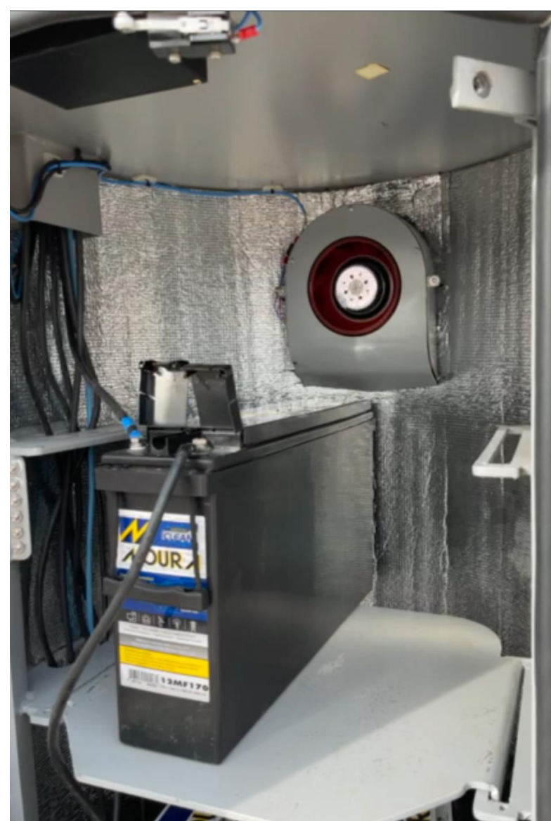
Ventilação Bateria
