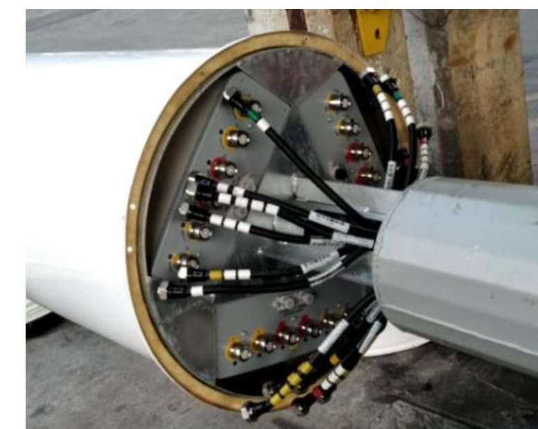
Cabos Fider 1/2" – Topo do Poste
